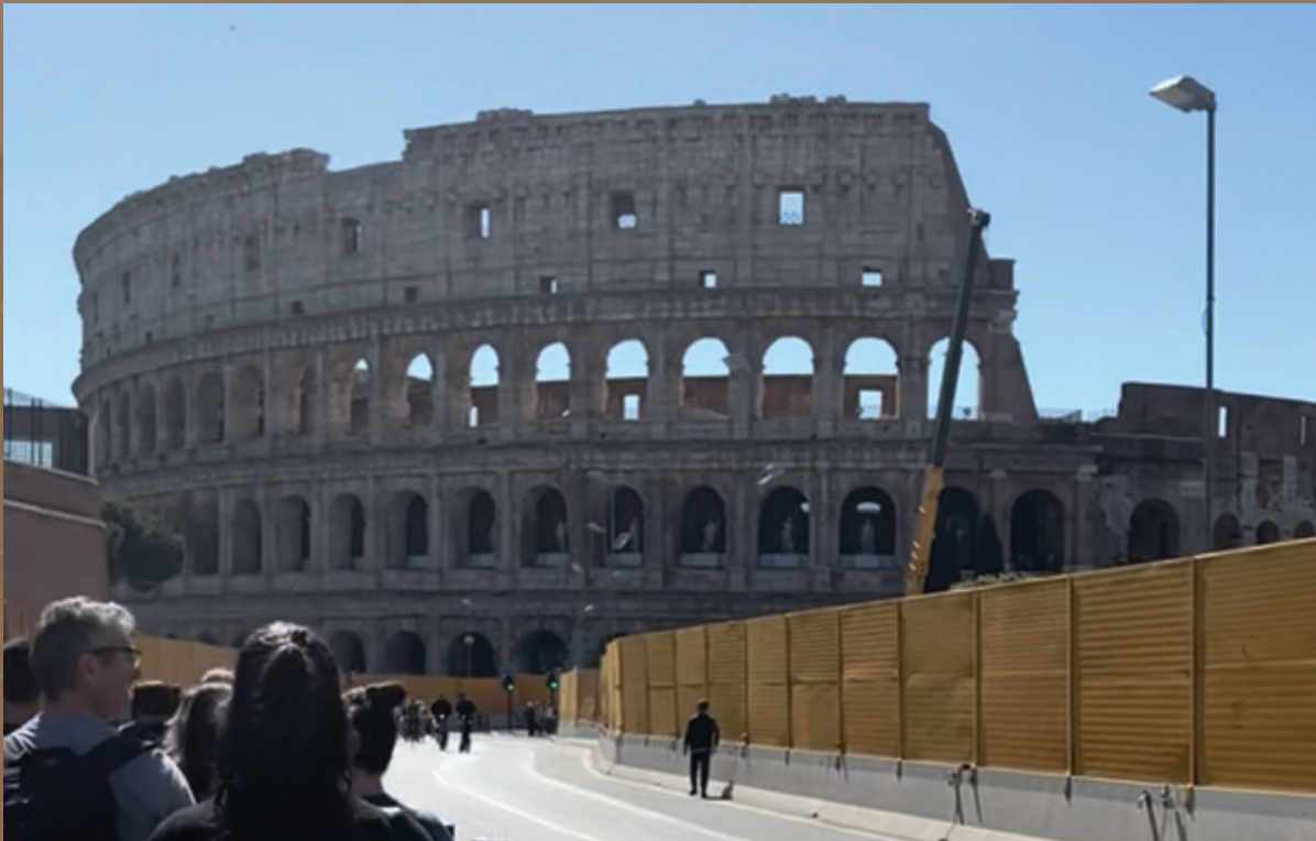
Trabajos para la construcción de línea del metro cerca del Coliseo Romano, Italia. © RERM
