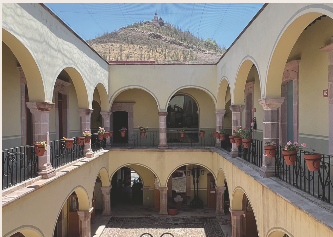
Instalaciones del RWHIZ © RERM
